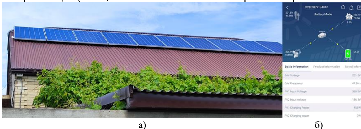
Рис. 6. ФЭС (а); режим ее работы в данный момент (б). Можно дистанционно смотреть и управлять.
